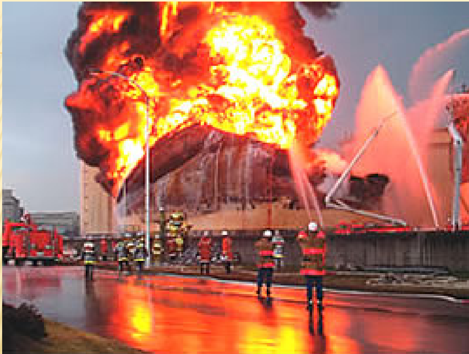
石油タンクの全面火災 Total fire of a petroleum tank
